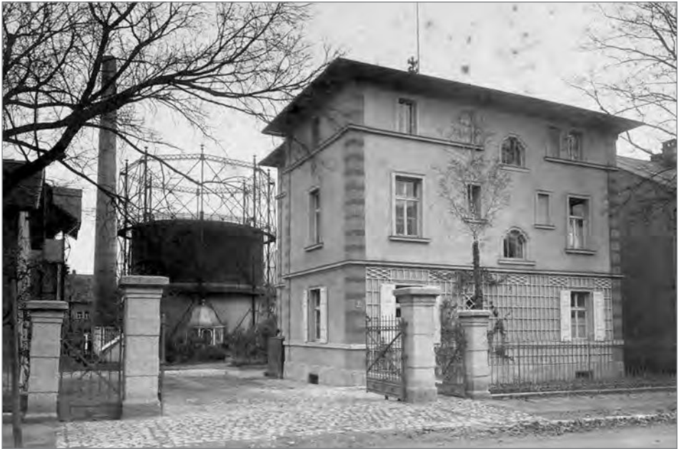
Abb. 10. Rückseite des Wohnhauses zum Gaswerk Kitzingen, Würthstraße 5
